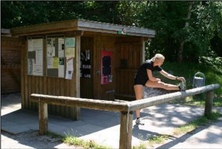
Eksempel 3: Det er vigtigt, at der er mulighed for at vente på hinanden i tørvejr og mulighed for at opbevare overtrækstøjet. Her ses et simpelt skur etableret i Blykobbe Plantage på Bornholm. Skuret rummer også formidling af ruter og mulighed for strækøvelser. Men der mangler dog mange servicefunktioner og mulighed for at komme indendørs.
