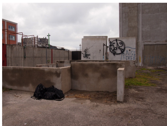
De nyere betonmure
