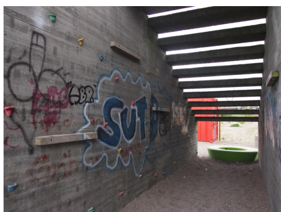
Klatregreb og træbjælker på indermuren.
