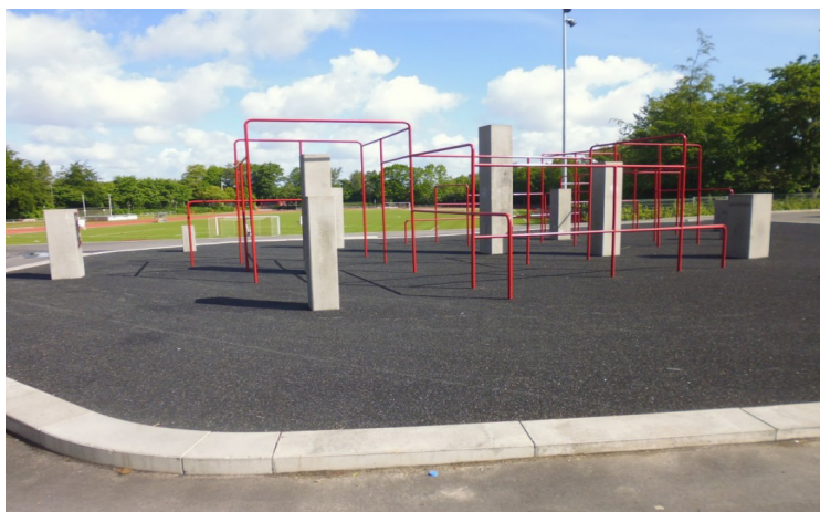
Kanten, der omkranser parkourfaciliteterne, er hævet 10-20 cm fra det omgivende asfalterede niveau og er anlagt med små niveauforskelle
