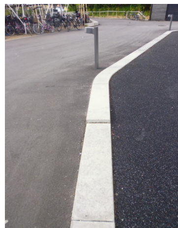
Kanten, der omkranser parkourfaciliteterne, er hævet 10-20 cm fra det omgivende asfalterede niveau og er anlagt med små niveauforskelle
