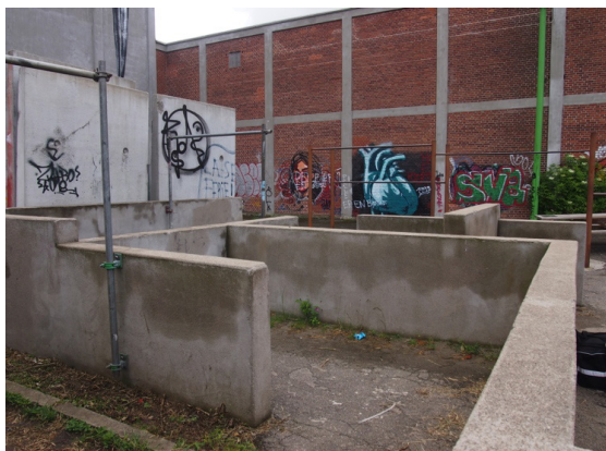
Mønster af lavere betonmure
