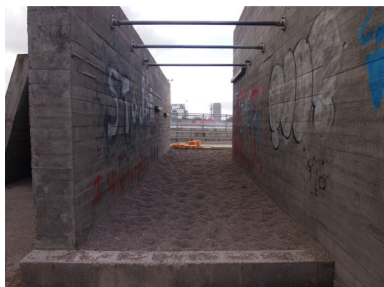
Mellemrum mellem de to betonstrukturer.
