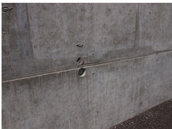
Mur med god ru overflade
