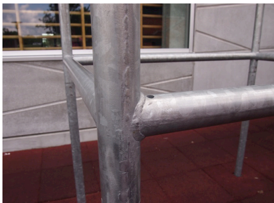
Rørsamling svejset, SG-Huset, Svendborg
