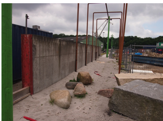
Bagsiden af den sydlige mur
