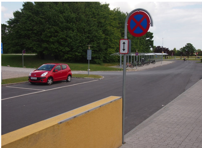
Murkonstruktion med metalkanter, hvor der blev placeret et skilt (tv.)
