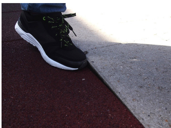
Flisekant holder fliserne, som er lagt på hårdt underlag, sammen.
