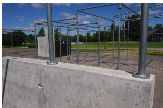
Stabilisering ved montering i betonmur
