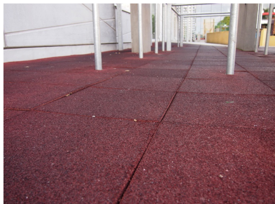
De røde faldunderlagsfliser vurderes at være en billig, men ikke en langtidsholdbar løsning
