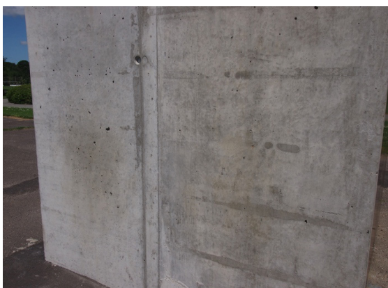
Mur med god ru overflade
