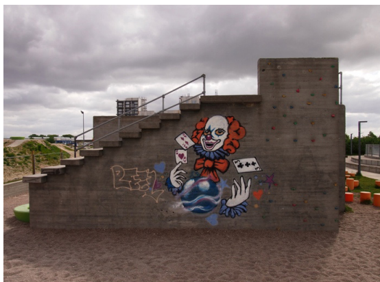
Den store betonstruktur med trappe og klatrevæg.
