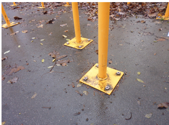
Rails boltet fast til asfalten
