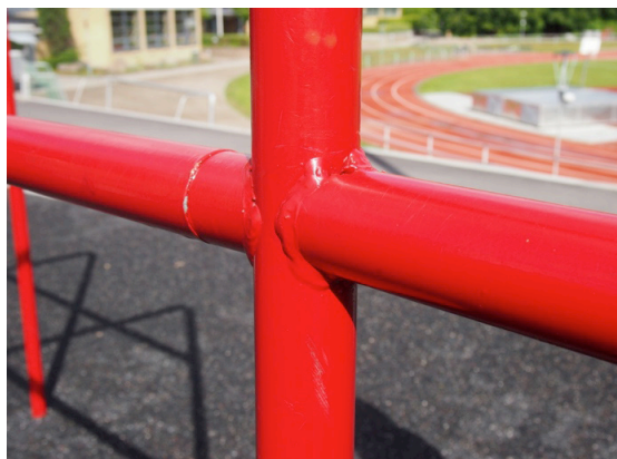
Rørsamling svejset, Ny Bagsværd Skole, Bagsværd
