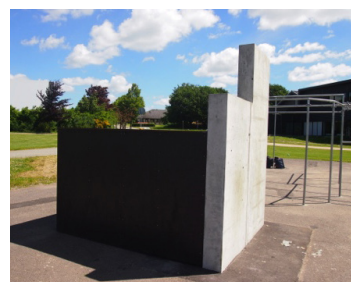
Betonnur med trækasse
