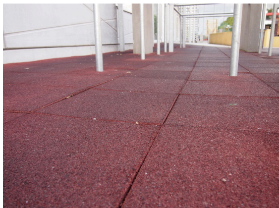
Faldfliser ved SG-Huset, Svendborg
