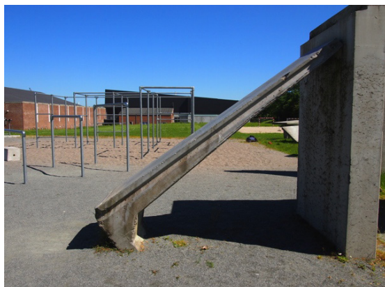
Betonhjørne danner en stabil skråmur
