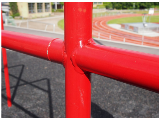
De røde railstativer er svejset sammen
