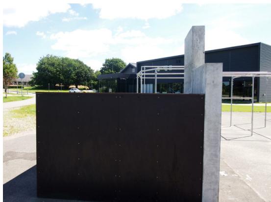
Betonvæg med trækasse
