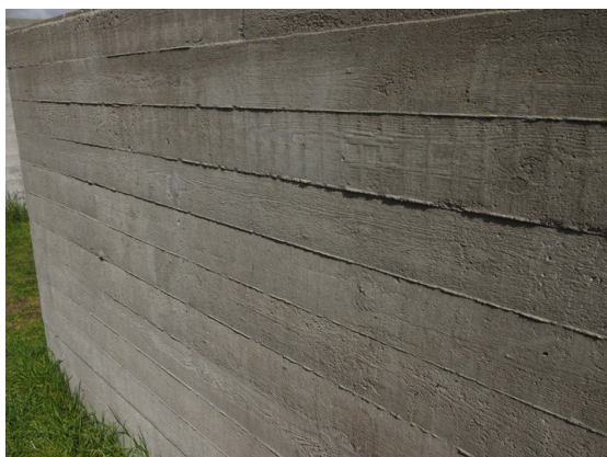
In situ-støbte betonmure med spor efter træplankerne.
