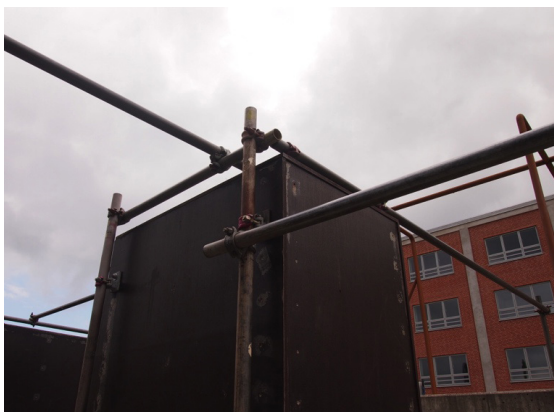
Rails monteret på palletårn
