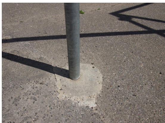
Rør nedstøbt i betonfundament i asfalten, Hinnerup Parkourpark.
