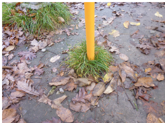
Rails støbt ned i betonfundament i jorden.
