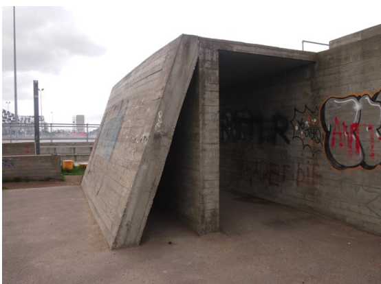
Skråmur på den ene store betonstruktur.
