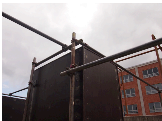
Rørsamling med clamp der giver mulighed for nem justering af railsene, Odense Havn
