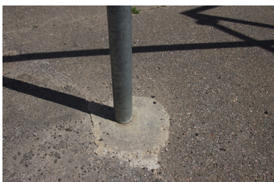
Stabilisering i fundament
