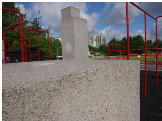
Betonstolpernes overflader og kanter er tilpas ru.
