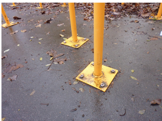
Rør fastgjort til asfalt med grundflage og bolte, Bobleplads, København
